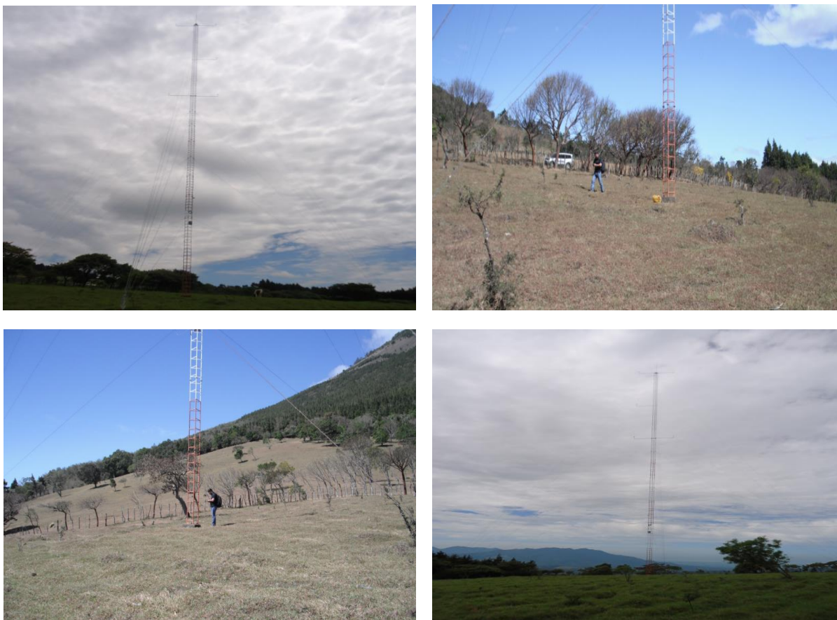
Ilustración 7: Estación de medición No. 0150, finca La Sabana
