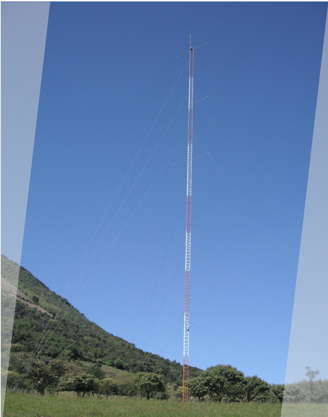
Ilustración 8: Torre y equipo de medición utilizado en finca La Sabana.
