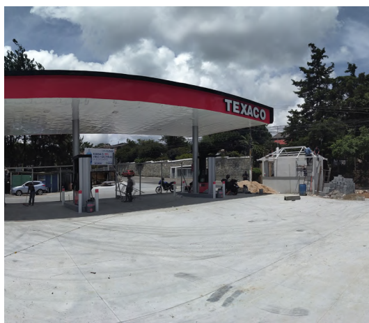
Estación Los Pinos, calle Los Pinos 14-15 Zona 7, Municipio de Mixco, Departamento De Guatemala.
