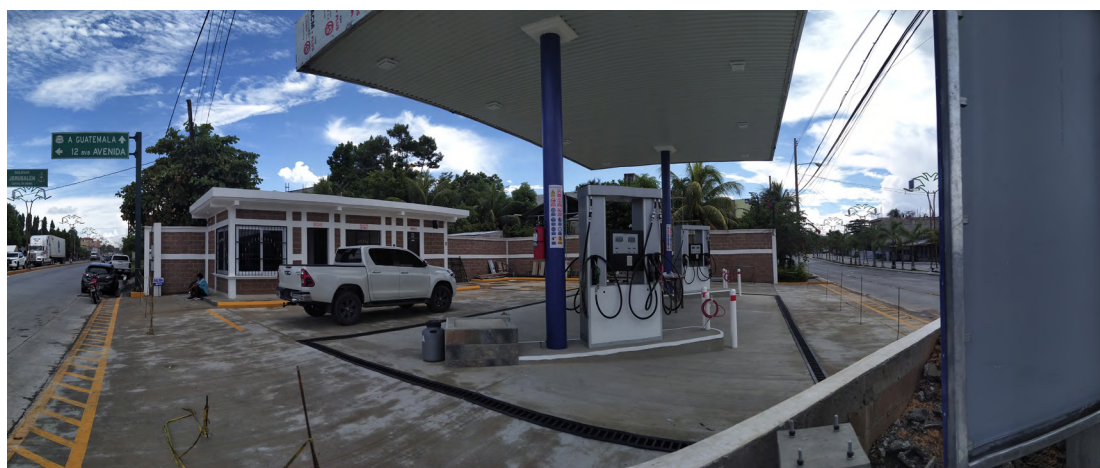
Estación de servicio La Bendición, 20 calle y 12 avenida, Municipio De Puerto Barrios, Departamento de Izabal.
