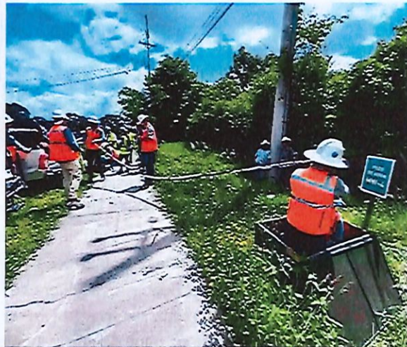
Foto 2 Utilización de bomba, para extracción de agua.
