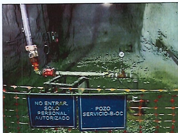
Foto 12 Visita al Pozo de servicio-B-OC
