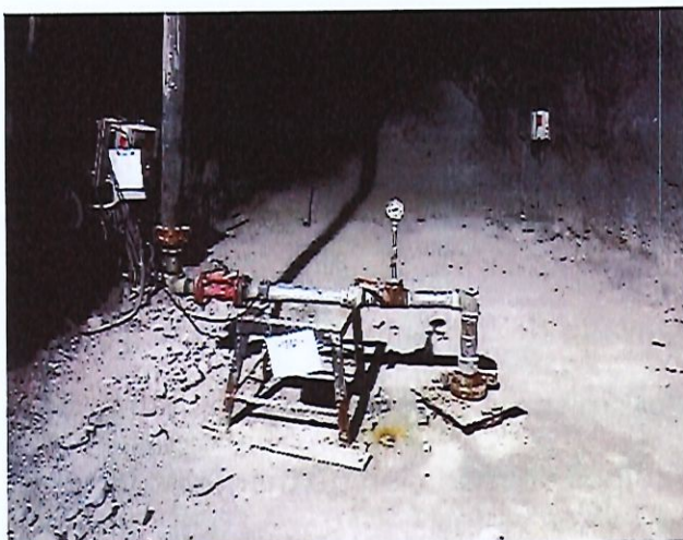
Foto 13 Visita al pozo Serv-A-OC
